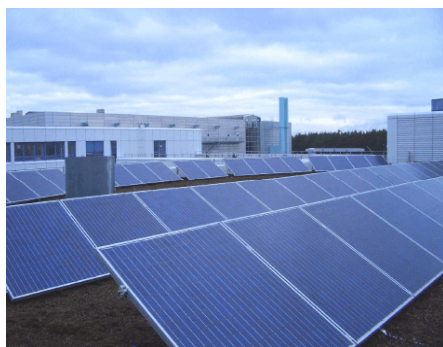
Die neu installierten Solarzellen auf dem Dach des IISB-Gebäudes; Newly installed solar panels on the roof of the IISB building.
